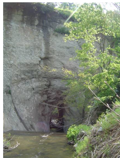
写真-1 東川右支川河川トンネル流入口
